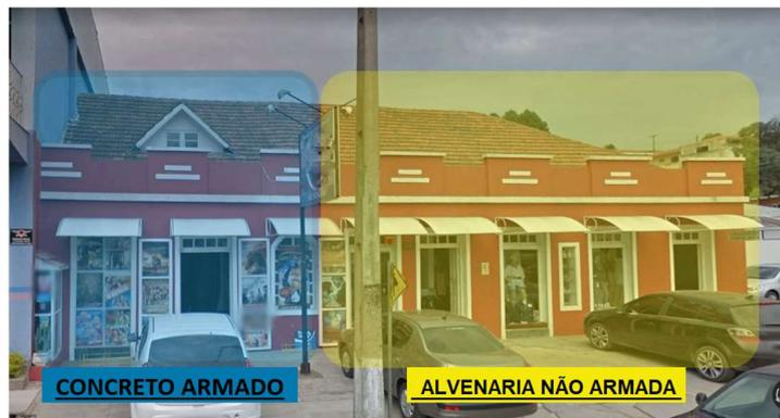
FIGURA 3: FACHADA COM INDICAÇÃO DAS TIPOLOGIAS CONSTRUTIVAS
