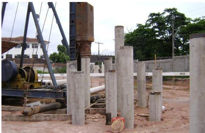
FIGURA 03 – ESTACA CRAVADA DE CONCRETO
