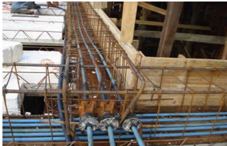
FIGURA 3: CORDOALHAS ENGRAXADAS NÃO ADERENTE FONTE: CONCREFATO (2014)
