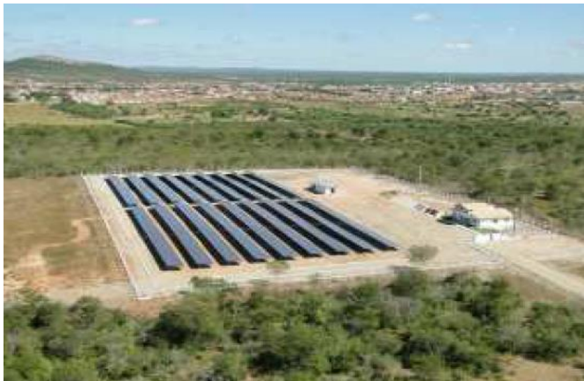
FIGURA 04: CENTRAL FOTOVOLTAICA DE TAUÁ / CE FONTE: MPX (2013)
