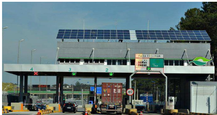
FIGURA 09: SISTEMA FOTOVOLTAICO INSTALADO NA PRAÇA DE PEDÁGIO BATISTINI FONTE: BLUE SOL (2012)
