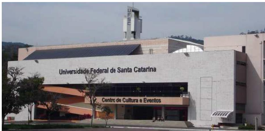
FIGURA 07: SISTEMA INSTALADO NO CENTRO DE CULTURA E EVENTOS DA UFSC FONTE: BENEDITO (2009)
