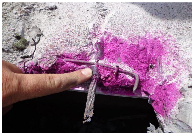
FIGURA 10 – VERIFICAÇÃO DA CARBONATAÇÃO E PH DO CONCRETO. FONTE: AUTORES (2016).
