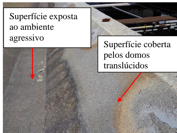
FIGURA 06 – COMPARATIVO DE DESGASTE. FONTE: AUTORES (2016).
