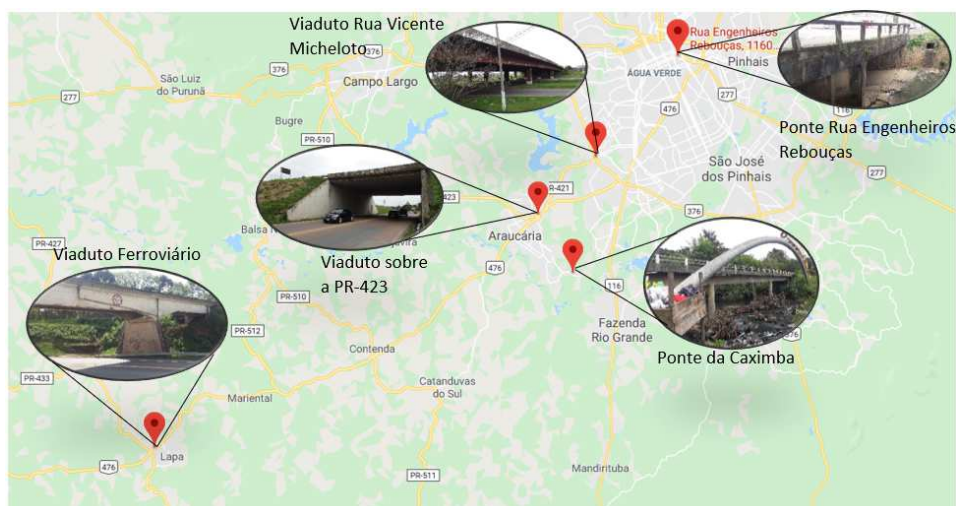
FIGURA 2: LOCALIZAÇÃO DAS OAES INSPECIONADAS. FONTE: AS AUTORAS, 2019.
