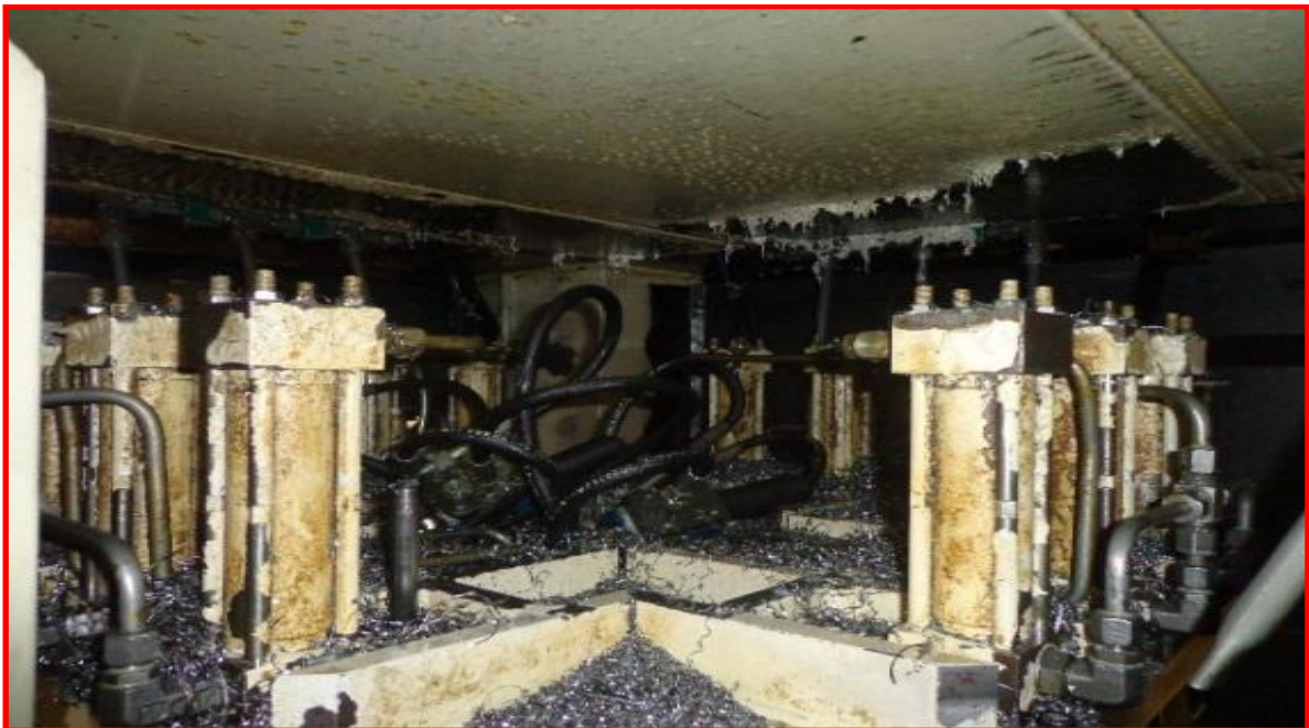
FIGURA 3 - MÁQUINA NA PRIMEIRA INSPEÇÃO FONTE: EMPRESA ESTUDADA
