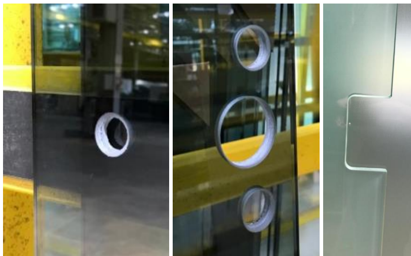
FIGURA 3 EXEMPLO DE MARCAÇÃO E RECORTE ACABADO FONTE: OS AUTORES (2019)
