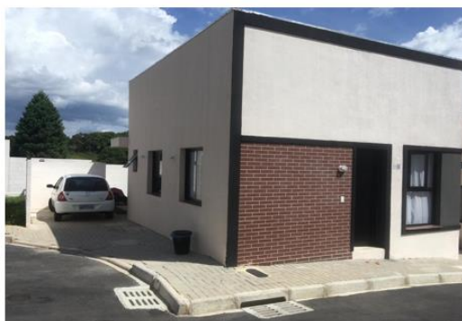
FIGURAS 2 E 3: EM ARAUCÁRIA: RESIDENCIAL EM ALVENARIA CONVENCIONAL, E RESIDENCIAL EM PAREDES DE CONCRETO, RESPECTIVAMENTE. FONTE: OS AUTORES (2019).
