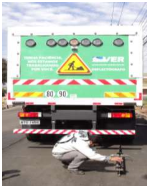
FIGURA 12 – ENSAIO VIGA BENKELMAN FONTE: OS AUTORES
