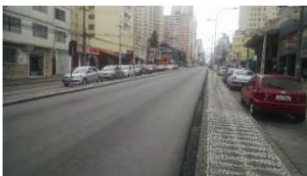
FIGURA 24 – LEVANTAMENTO VISUAL (II) DE DEFEITOS FONTE: OS AUTORES
