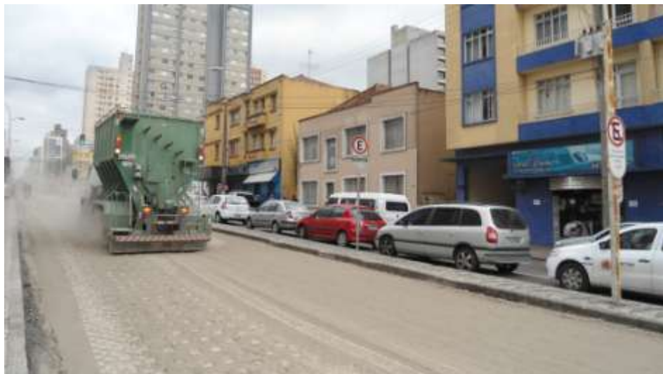
FIGURA 17 – APLICAÇÃO DO AGLUTINANTE HIDRÁULICO (CIMENTO) FONTE: OS AUTORES
