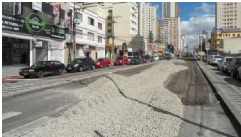
FIGURA 15 – ESPALHAMENTO DOS AGREGADOS FONTE: OS AUTORES
