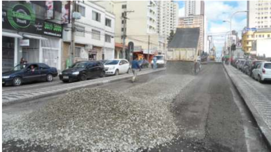
FIGURA 16 – ESPALHAMENTO DOS AGREGADOS FONTE: OS AUTORES
