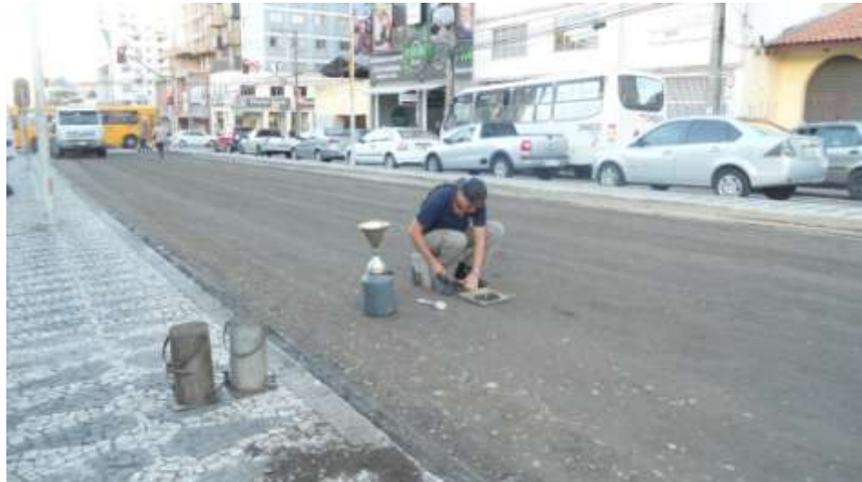
FIGURA 21 – CONTROLE TECNOLÓGICO DA APLICAÇÃO (DENSIDADE IN SITU ) FONTE: OS AUTORES
