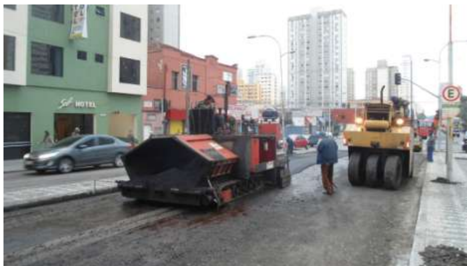
FIGURA 22 – CURA DO PAVIMENTO COM APLICAÇÃO DE MASSA ASFÁLTICA FONTE: OS AUTORES
