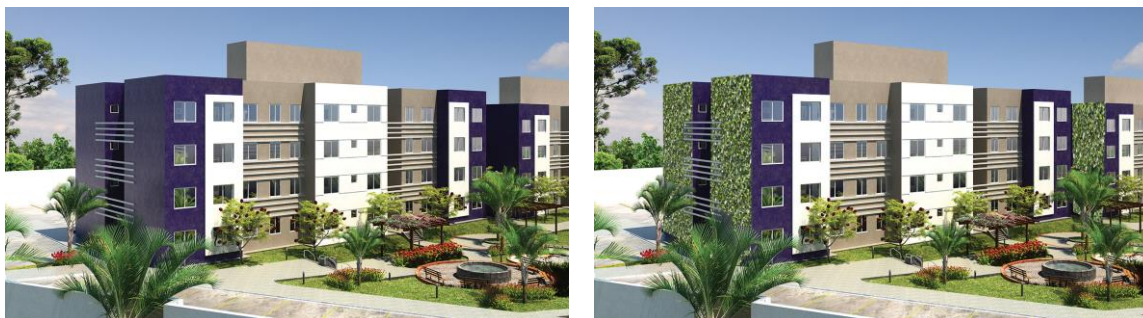
FIGURA 8: FACHADA SEM O JARDIM VERTICAL E COM O JARDIM VERTICAL – REDE DE CABOS FONTE: MONTE AZUL ENGENHARIA (2016) COM ADAPTAÇÃO DOS AUTORES (2019).
